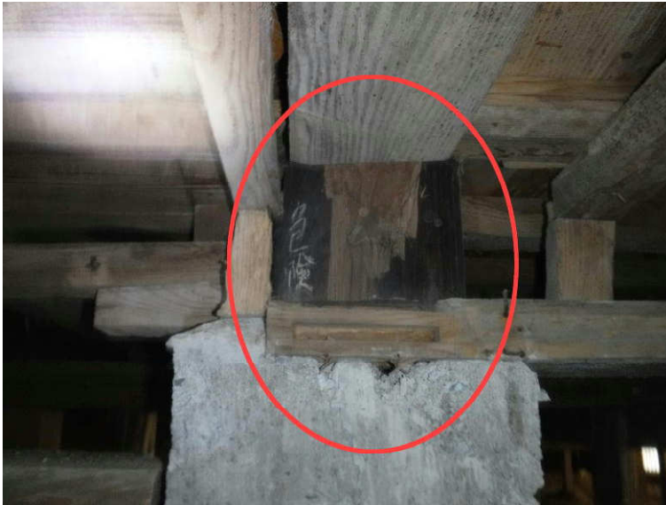
床下の写真です。
